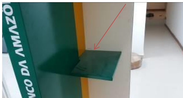
Detalhe da banquetta de apoio em chapa metálica
