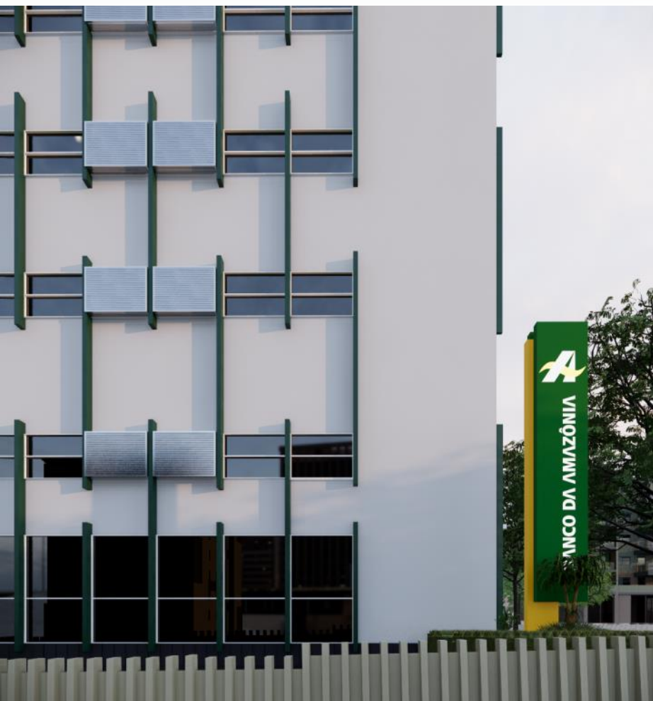
Detalhe da prumada de caixas suporte de Split/ACJ's
